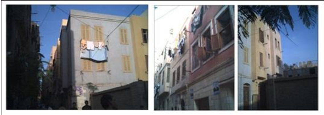
شكل ( 2 ) بعض المباني التي تم ترميمها بالدرب الاحمر
